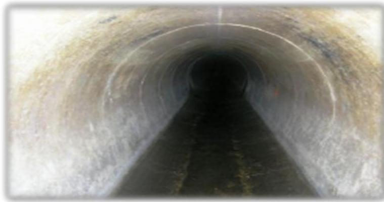
Figure VI.1 : conduite en béton
