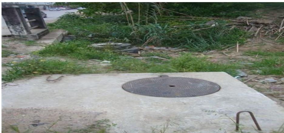
Figure II.7 : regards en béton avec tampon
