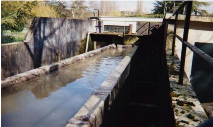
Figure VI.8 : Déversoir à seuil double
