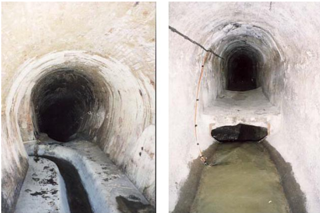
Figure VI.7 : Déversoirs à seuil frontal
