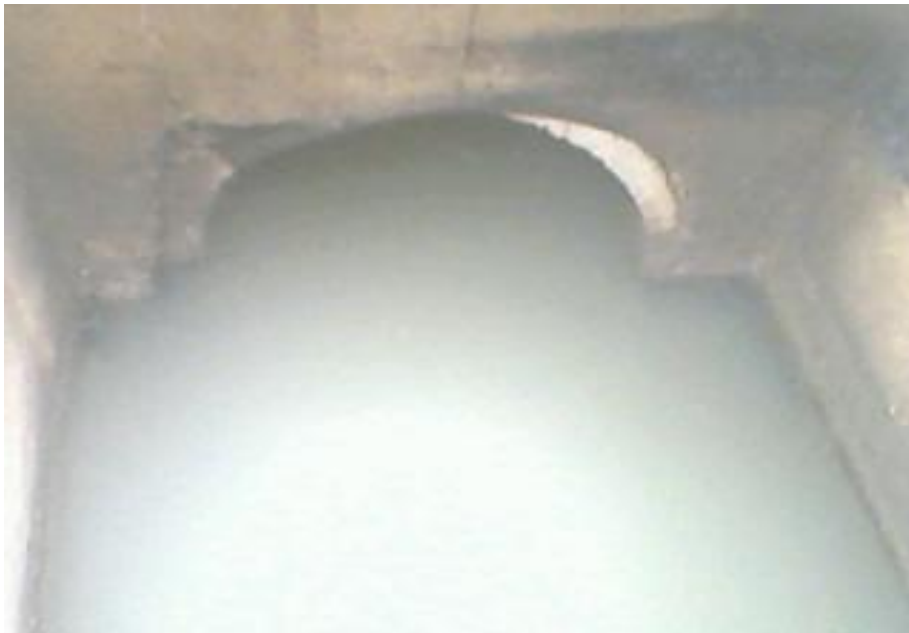
Figure II.5 : le collecteur \varnothing 800 presque en charge
