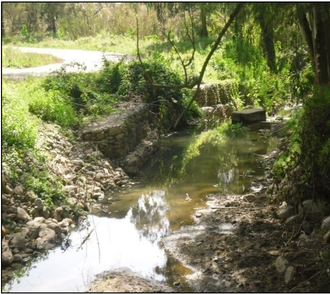
Figure IV.04 : Traversée de l'oued à l'intérieur du parc et raccordement des collecteurs (600-1000) au monolithe (2mx2m)
