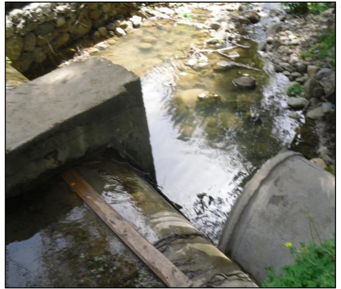
Figure IV.04 : Traversée de l'oued à l'intérieur du parc et raccordement des collecteurs (600-1000) au monolithe (2mx2m)
