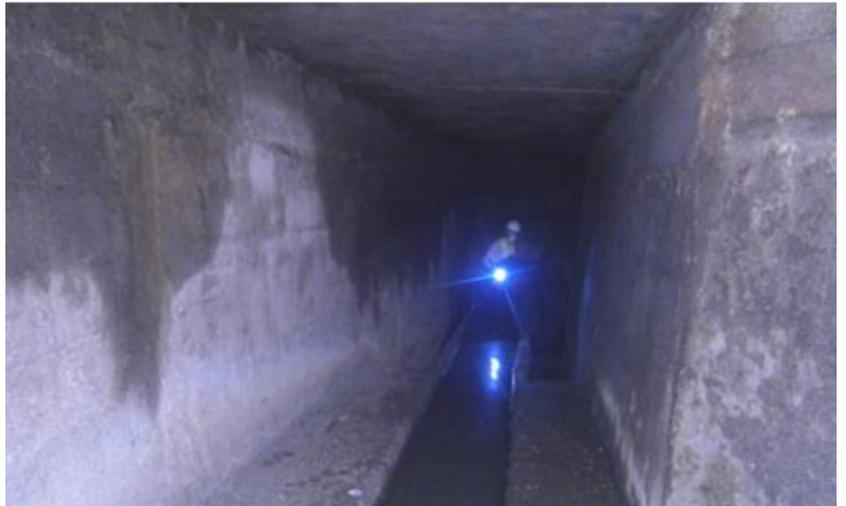
**Figure 6.1** : cunette et canal suspendu (photo prise le 31/12/2016)
