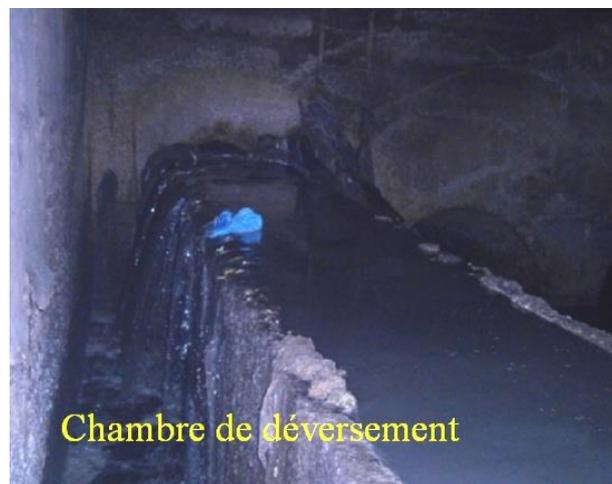
**Figure 2.7** : canal suspendu à double seuils déversant.
