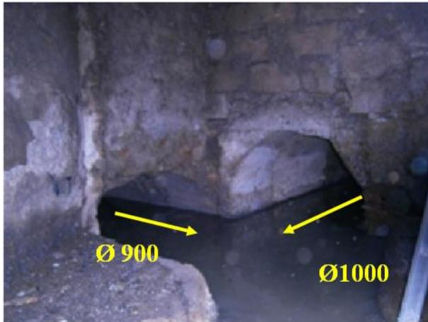
Les deux premier collecteur suscités sont combiné a l'entrée de l'ouvrage et traverse un couloire d'amener de 16,70m de long et de dimension (2,50x2,50)m et équipé d'une cunette en demi cercle de diamètre 0,70m pour atteindre la chambre de déversement.
