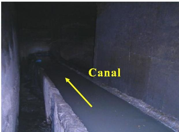
Arrivant à la chambre de déversement, la cunette devient un canal suspendu à double seuil déversant que les eaux usées domestique (débit temps sec) traversent pour atteindre le collecteur Ø700 eaux usées les dunes aval.
