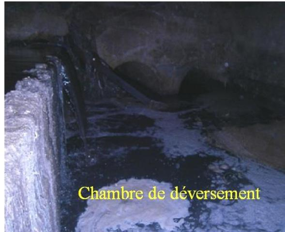
**Figure 2.9** : chambre de déversement. (photo prise le 31/12/2016)
