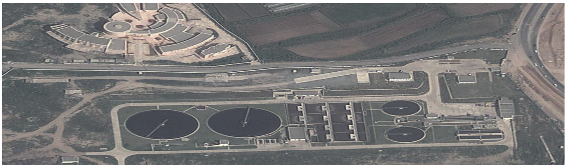
Figure III-2:Photo aérien present Ouvrages de traitement
