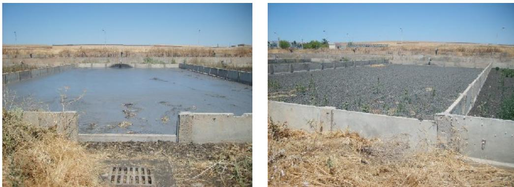
Figure. III.8 : Les lits de séchage
