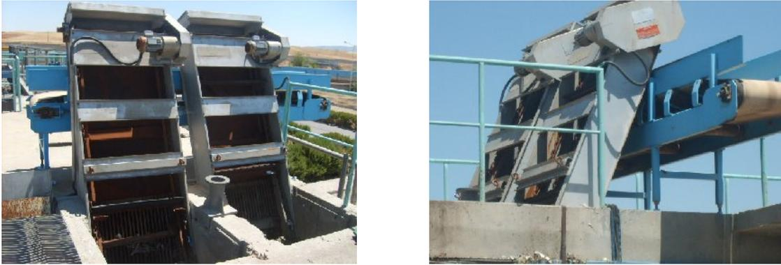
Figure. III.1: Le dégrillage
