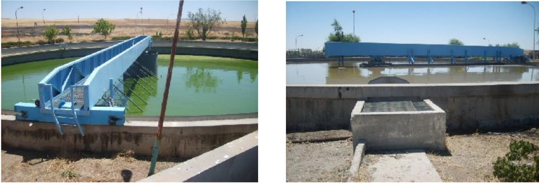
Figure. III.3 : Le décanteur primaire
