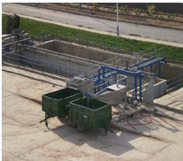
**Figure II.6: Classificateur de sable**
