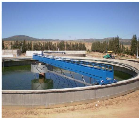
**Figure II.10 : Décanteurs secondaires**
