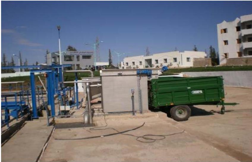
**Figure II.7 : Concentrateur de graisses**
