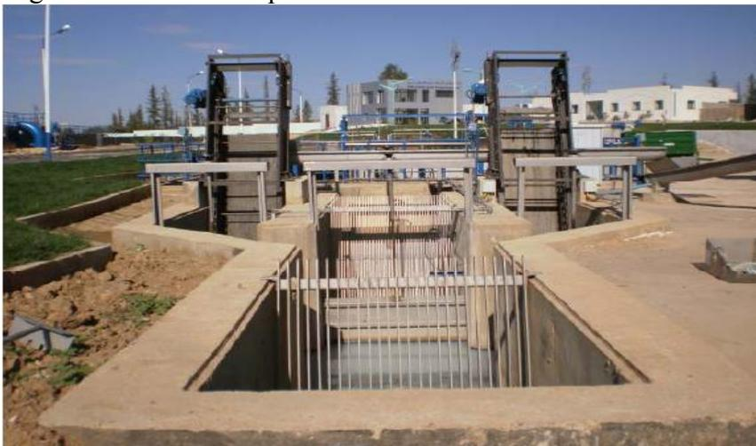
**Figure II.4 : Dégrillage grossier + fins**
