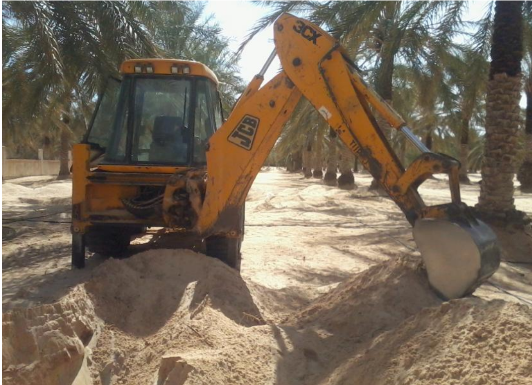
Fig.42: Pelle équipée en rétro_excavateur
