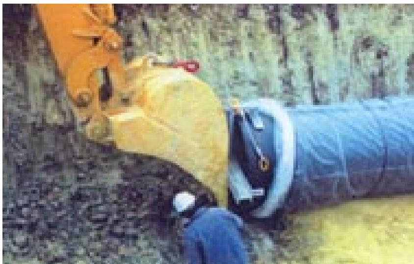
**Fig .V.5: Pose de conduites dans un terrain agressif.**
