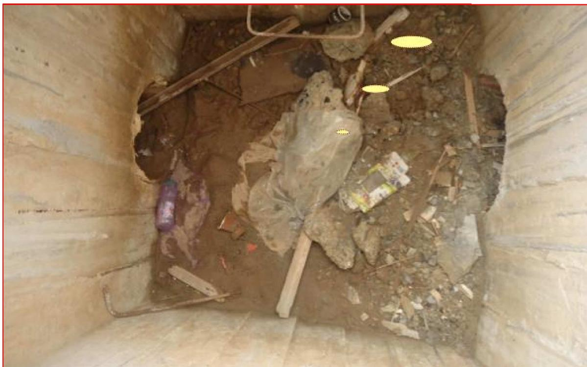
**Figure V.2.** Regard colmaté plein de dépôts dans le sous bassin 5 (Mai 2015)
