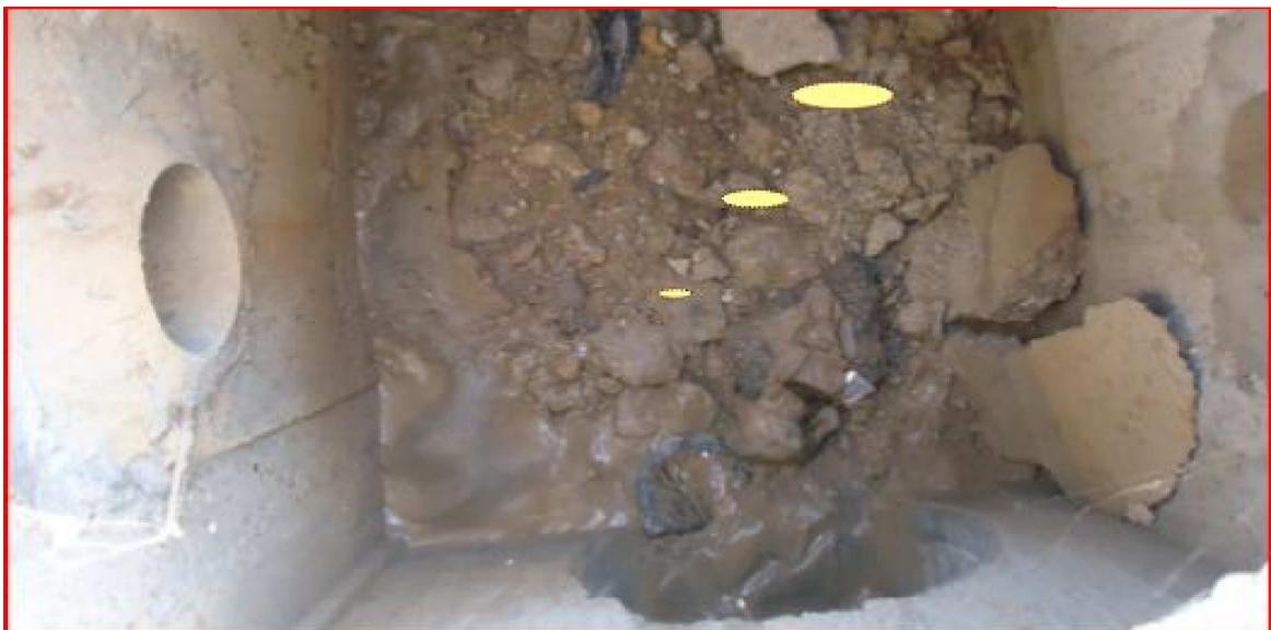
**Figure V.5 :** Regard colmaté, plein de dépôts dans le sous bassin 9.(Mai 2015)
