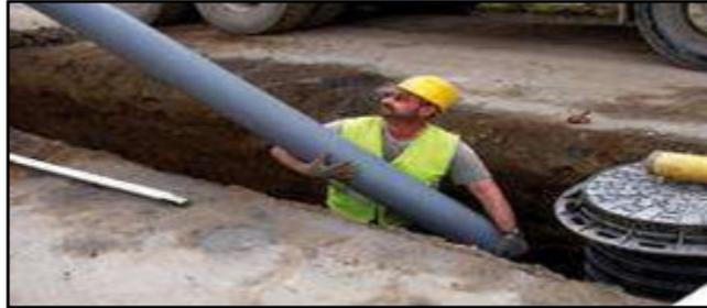
Figure VIII-2 Pose de la canalisation
