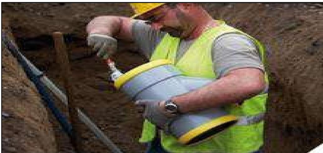
Figure VIII-4 La mise en place de l'adhésif à l'aide d'un pinceau
