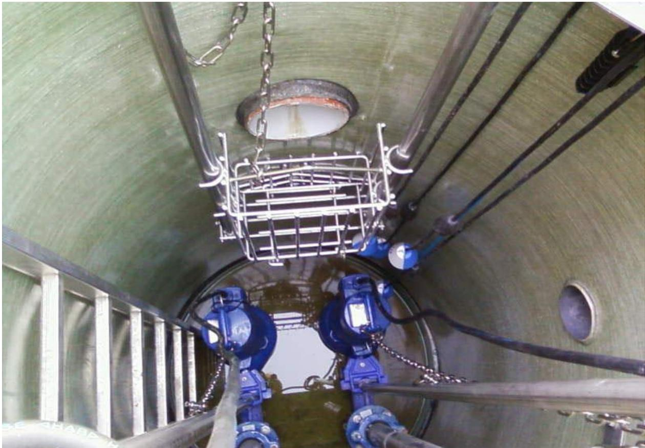
**Figure V-1:** Groupe électropompe d'assainissement de type submersible (immergé)
