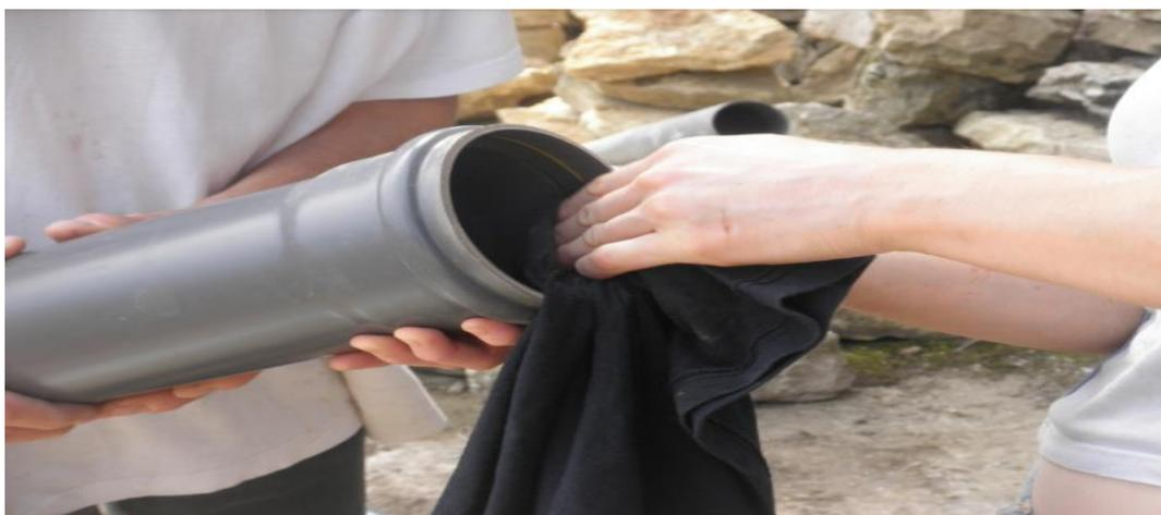
**Figure VI-2** : nettoyage de la partie à assembler
