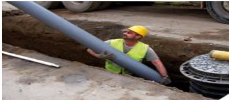
**Fig.VII.2** : pose de la canalisation
