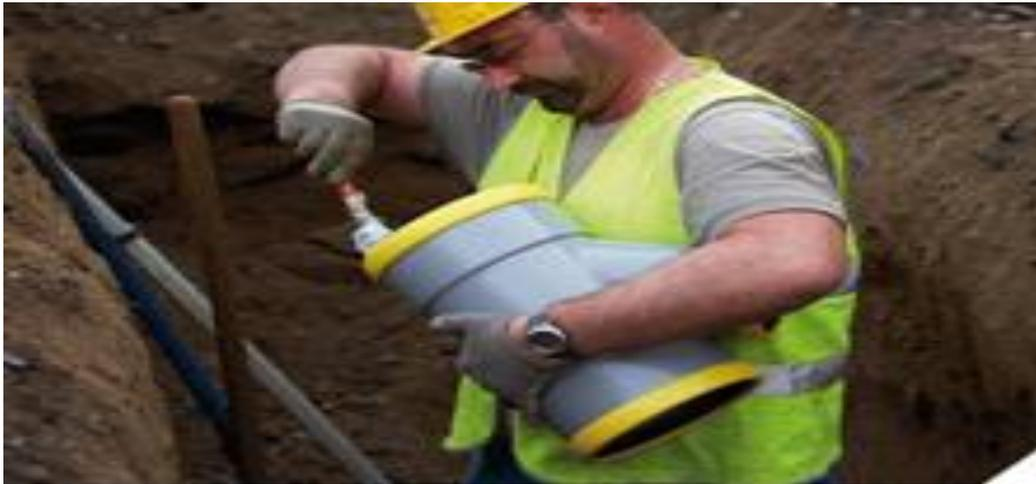
**Figure VII-4** : la mise en place de l'adhésif à l'aide d'un pinceau
