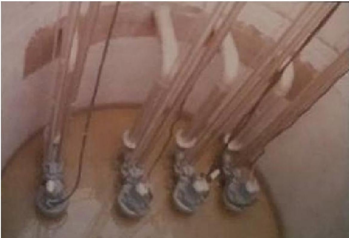
**Figure V.8:** Groupe électropompe d'assainissement de type submersible (immergé)
