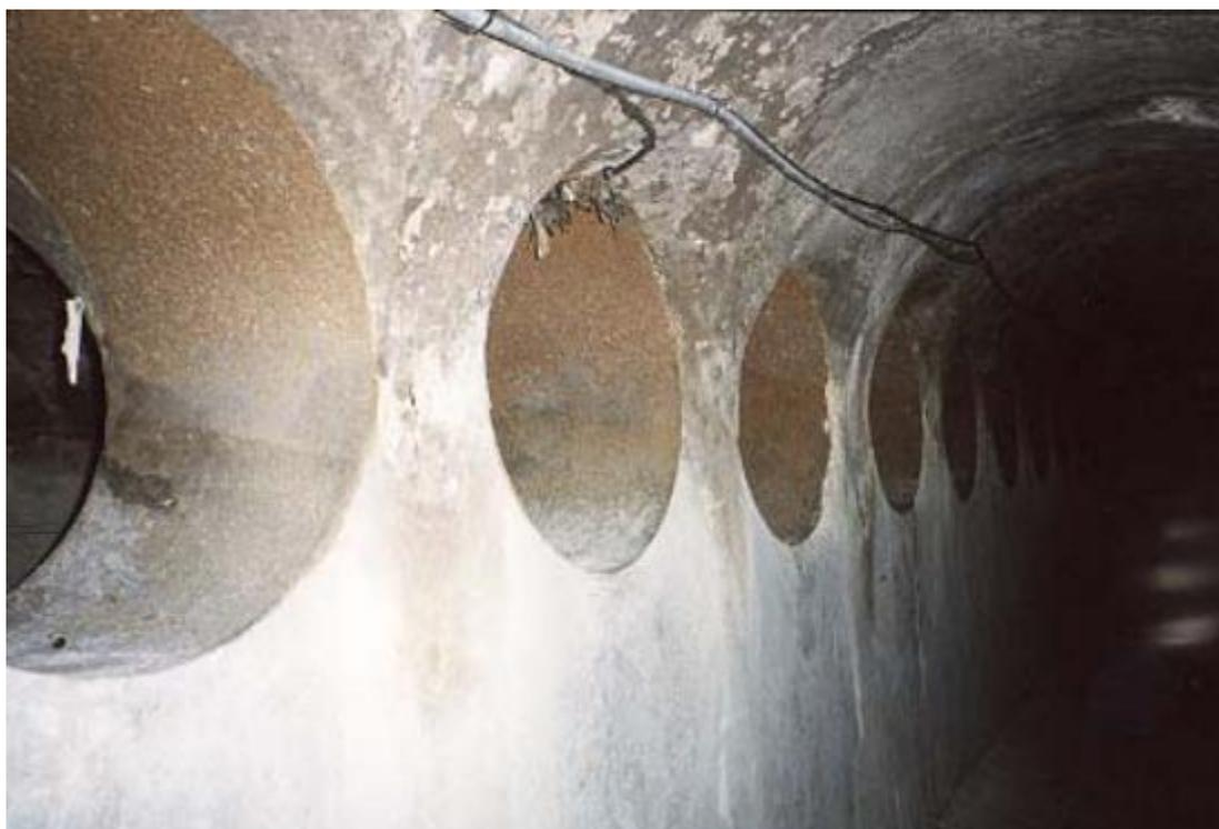
**Figure V.5:** Déversoir à trou dans le mur.
