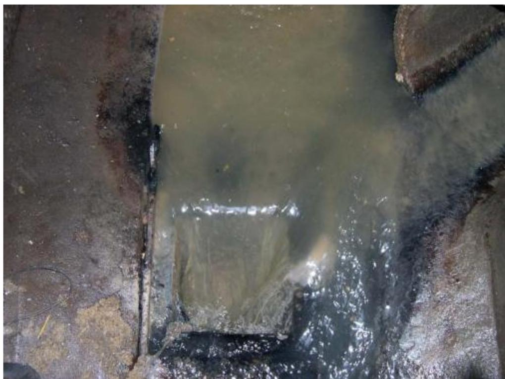
**Figure V.6:** Déversoir à ouverture de fond.
