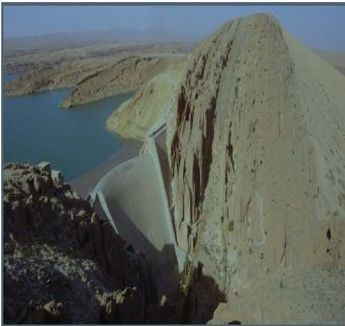
Figure I.9 : Barrage de Brézina
