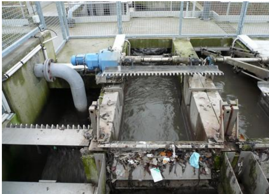
Figure N°III.3 : Dégrilleur
