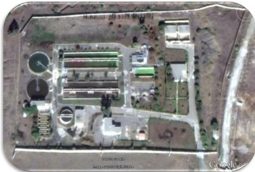
Figure N°III.1 : Photo aérienne de la station d'épuration de THENIA (source: google earth)
