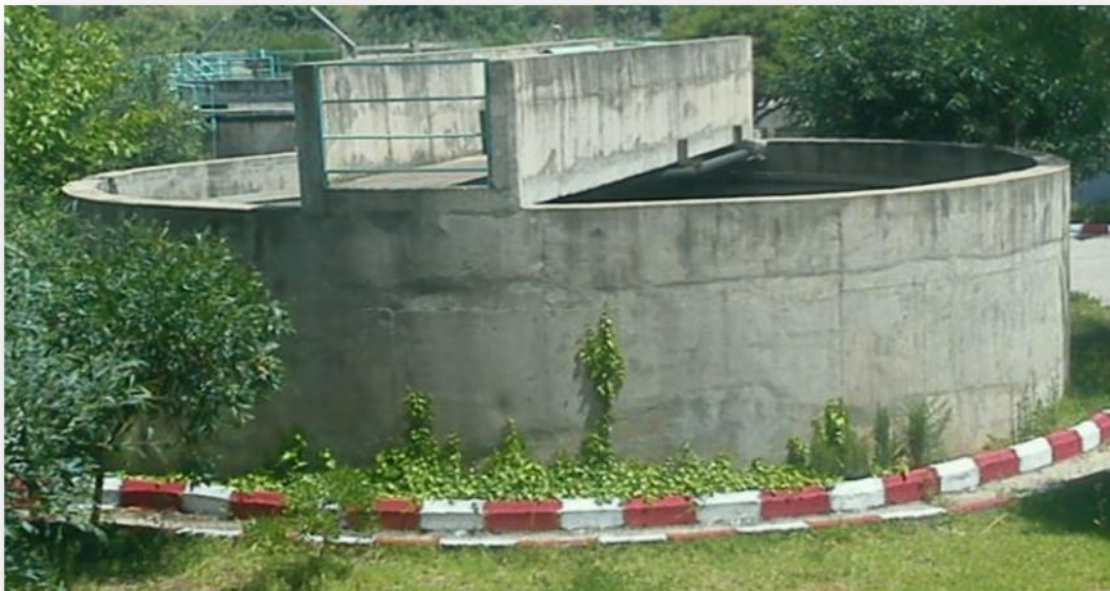
Figure N°III.5 : Epaisseur des boues.
