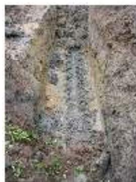
**Fig 40 : Chantier réalisé dans de mauvaises conditions. Sol hydro morphe, limitant la pénétration de l'eau vers les drains**
