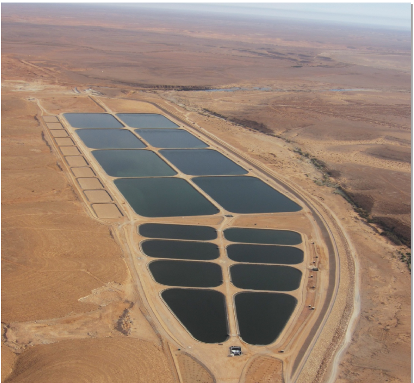
Figure II. 2 : Vue en dessus de la lagune d'El Atteuf
