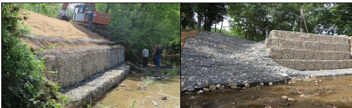
Figure I.25. Travaux de protections des berges d'un cours d'eau.
