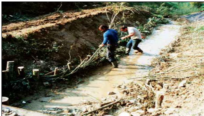
Figure I.29. Technique du génie végétal.
