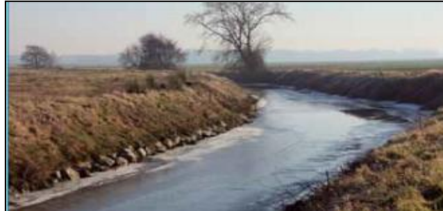
Figure I.22. Enrochement et recalibrage sur le Dhuy à Sandillon.
