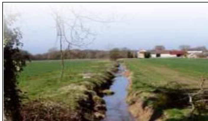
Figure I.21. Rectification et recalibrage à Servon 1986. (source : Michel Bramard,(86))
