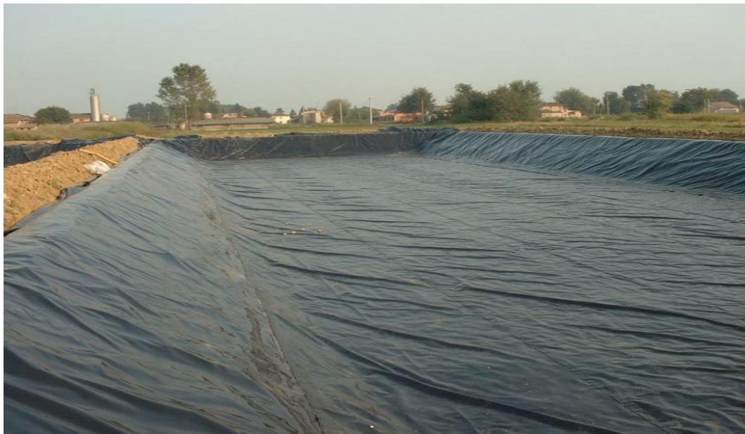
Figure 12 : lagune étanché par géomembrane
