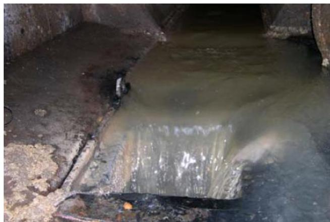
**Figure VI.2 :** Exemple d'un déversoir à ouverture de radier. **Source:VASQUIZ**
