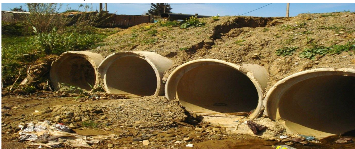
Figure I.1 : Passage provisoire sur la RN24 (oued Emak)
