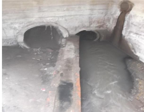
**Figure II.6:** Déversoir Dorage Rj05
