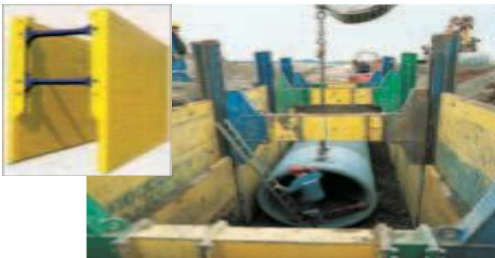
**Figure VIII.2 :** Exemple de blindage.**VIII.5.9 Largeur minimale de tranchée**
