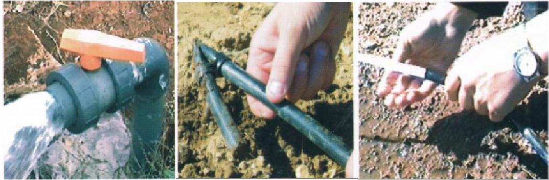
Figure VI. 14: Purge du réseau
