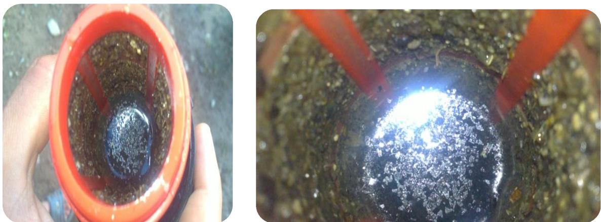
Figure III.15 - L'état du filtre du réseau N°2 (différentes vues)
