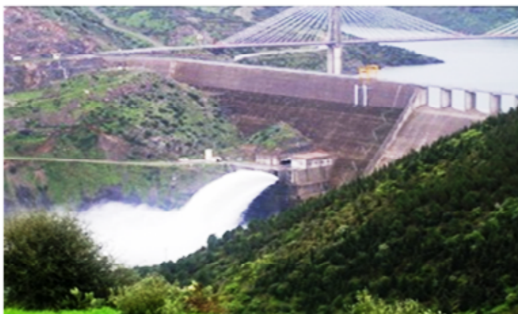
Fig. I.8 : Barrage de Beni-Haroun
