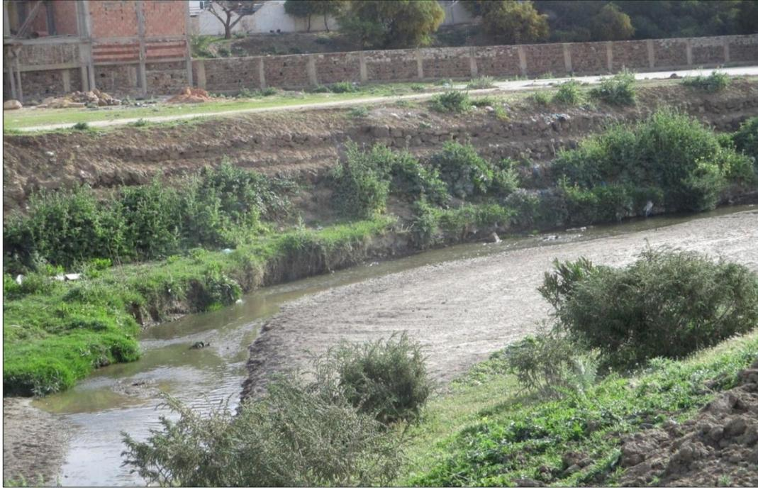
**Photo N°3 :** Protection en gabionnage au niveau du talus droit
