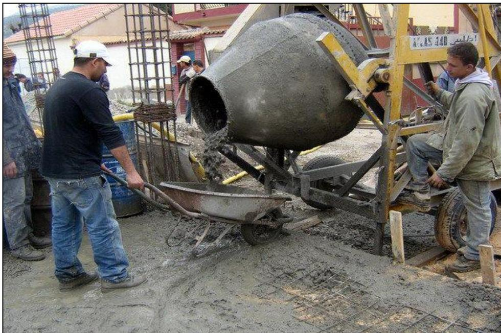
**Figure V.5 :** bétonnière en cours de fonctionnement.
