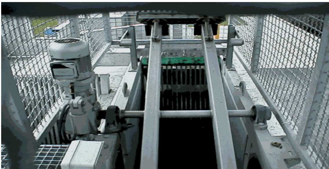
Figure IV.3 : les grilles mécaniques
