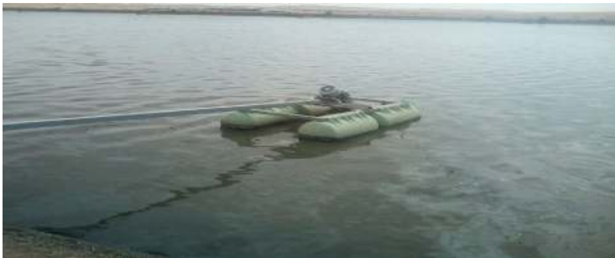
PHOTO3 : Aérateurs de surface flottante.
