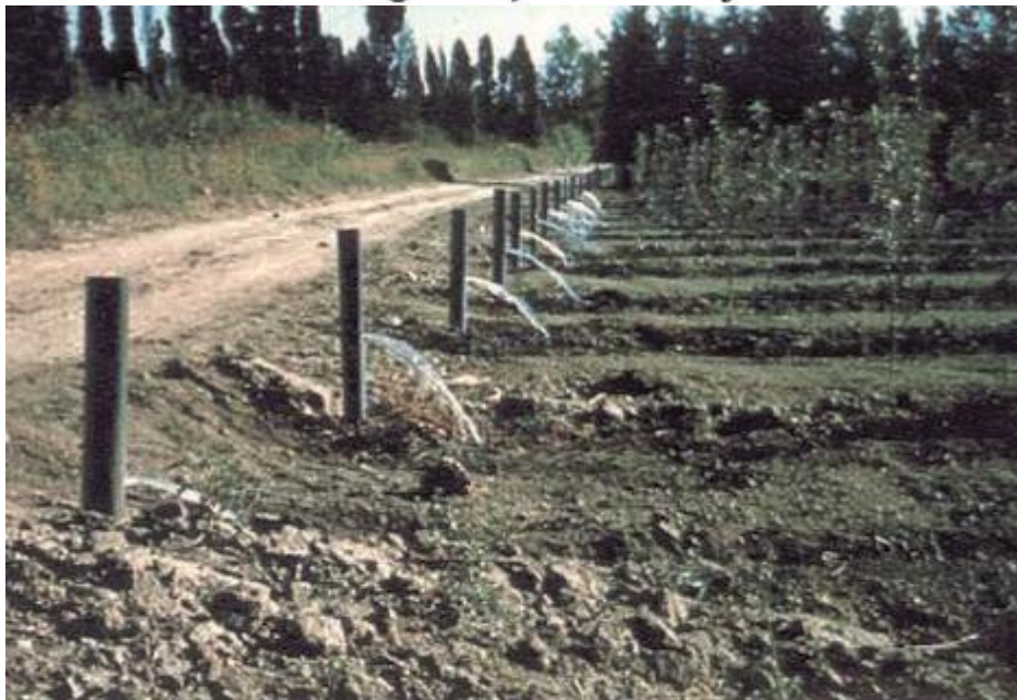
Figure 38:tuyau enterré avec canne (système californien)
