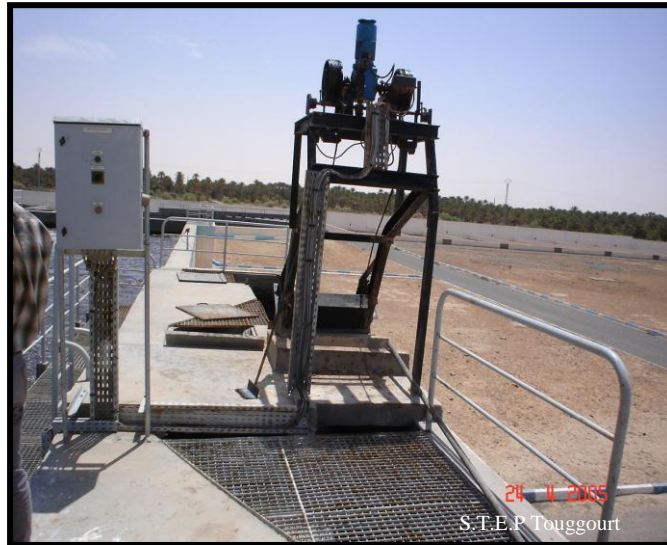
Figure III.1 Degrilleur mécanique
