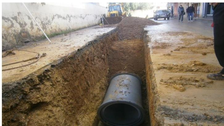
**Figure IX.5 : Pose de la canalisation**
