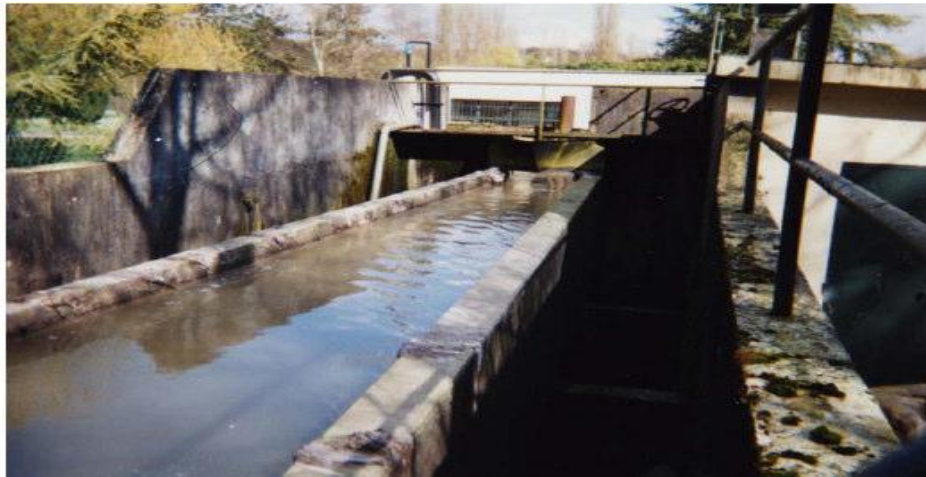
Figure V.2 Exemple de déversoir à seuil double
