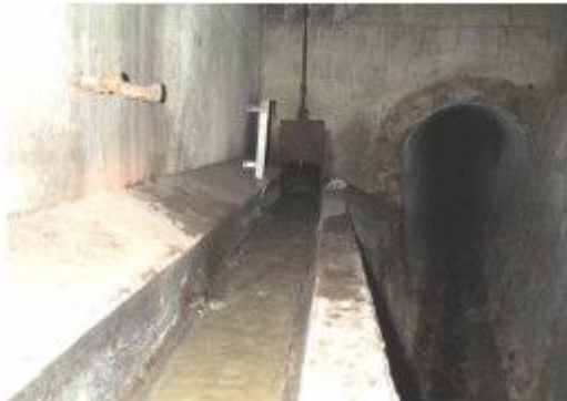
Figure V.1 Exemple de déversoir latéral à seuil simple
