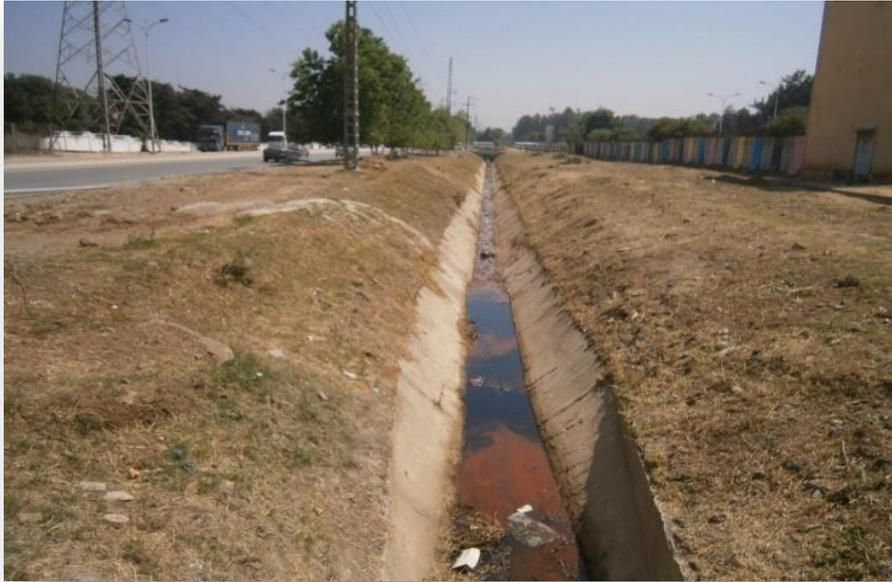
**Fig. III-3 : Caniveau trapézoïdal (2,20x0,80x1,50) qui se longe la voie « C » et qui se déverse au niveau de l'oued Biar (avril 2018)**
