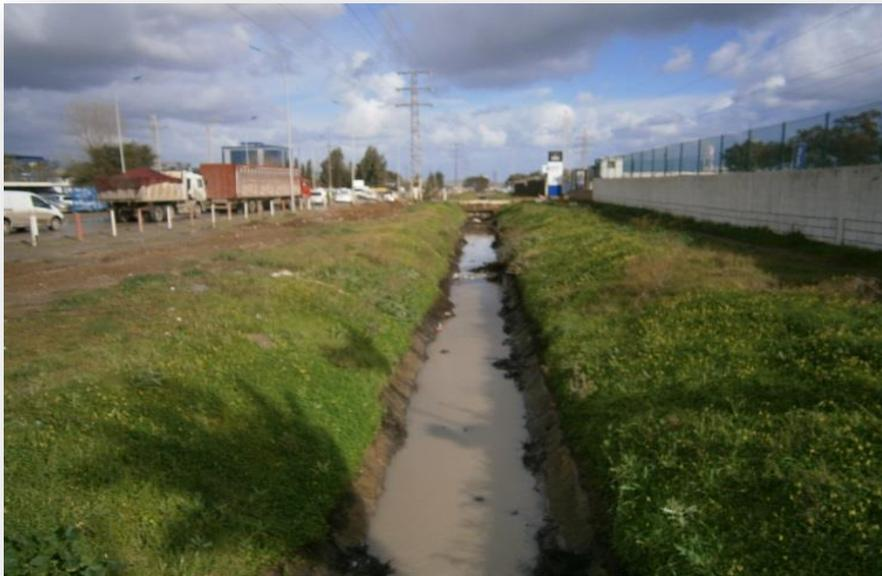
**Fig. III-2 : Caniveau trapézoïdal (3,50x0,80x1,50) qui se longe la voie « B » et qui se déverse au niveau de l'oued Boureah (avril 2018).**
