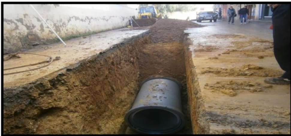
Figure IX.3. Pose de la canalisation ;(10/06/2018).
