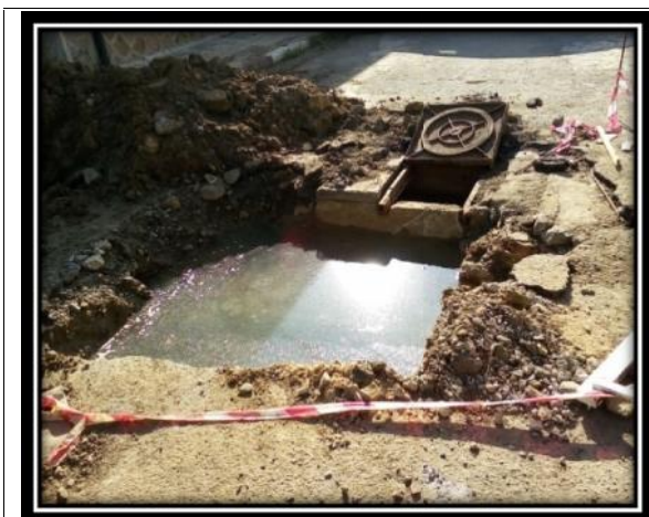
Figure III.1. Représente un débordement d'un regard ; (07/05/2018)
