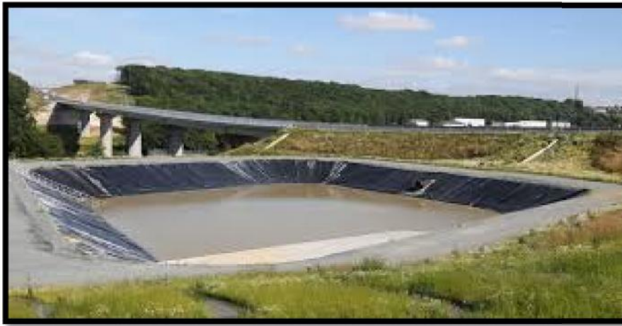
Figure VIII.5. Bassin de rétention sec à ciel ouvert. Source ( https://www.a150-albea.fr/la150-et-lenvironnement/eau/ )
