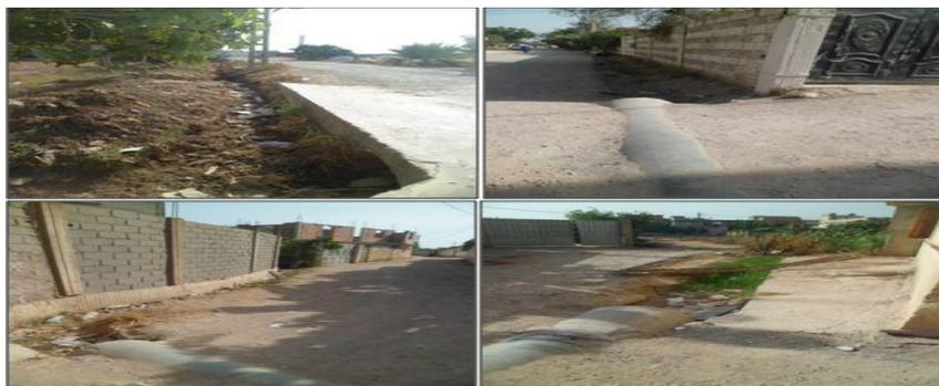
Figure III-I: les caniveaux d'évacuations des eaux pluviales
