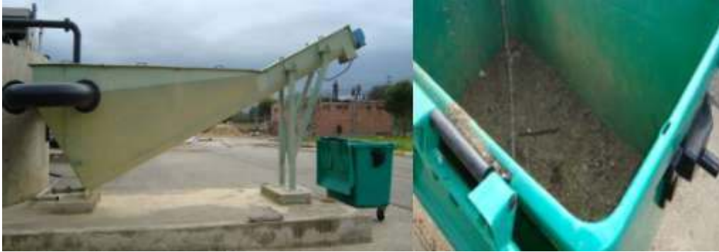
Figure II-6: Le classificateur des sables
