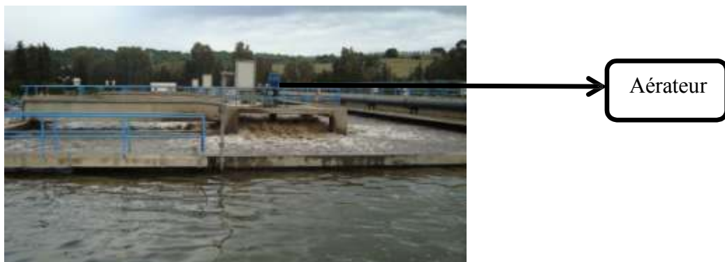
Figure II-8: Bassin d'aération
