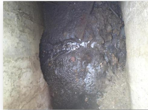
**Figures II.4 :** la présence de débris d'origines diverses et dépôts
