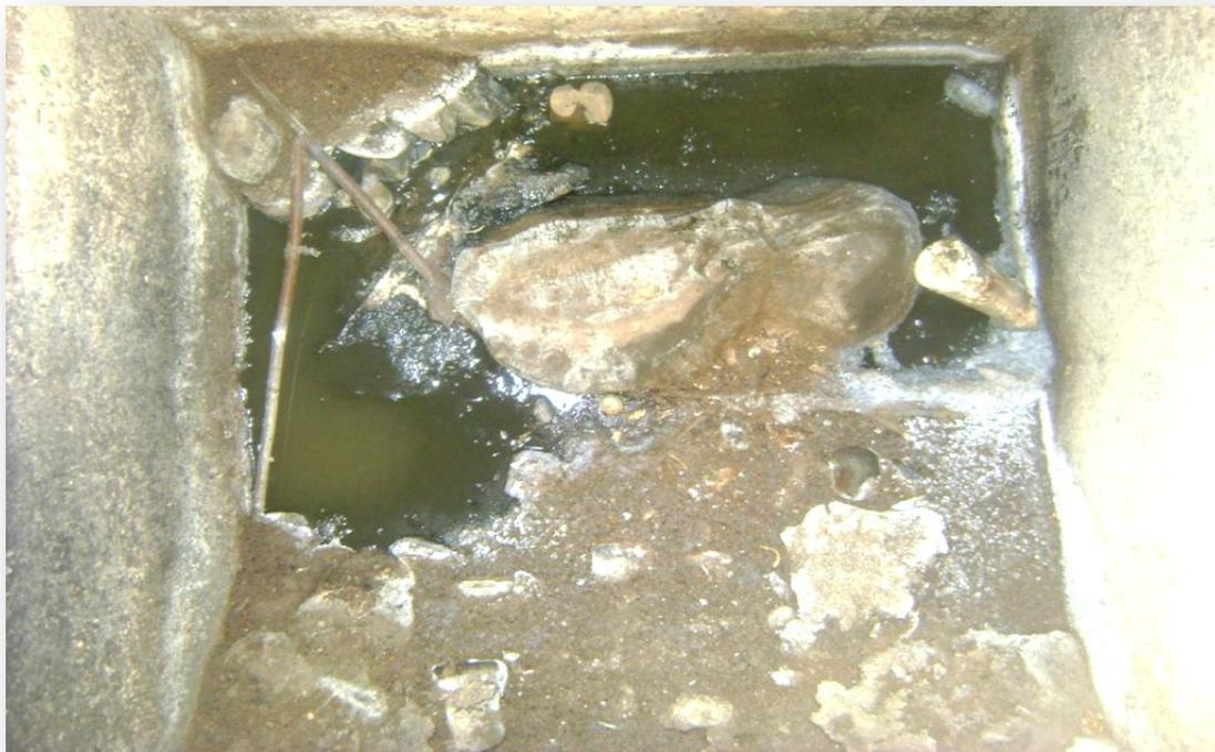
**Figure II.5 :** la présence des dépôts, pierres et déchets. L'amont et l'Aval du regard sont complètement colmatés (Regard n°24). Source : DRE de MEDEA
