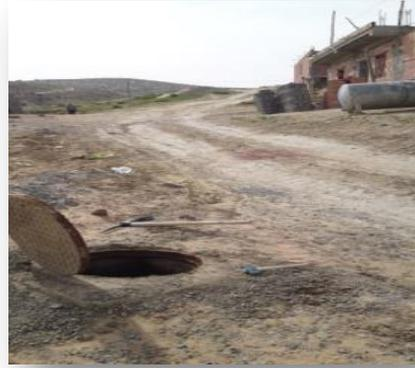
**Figures II.1 :** Présence de dépôts pouvant occasionner une grande gêne pour les écoulements (Regard n°6). Source : DRE de MEDEA
