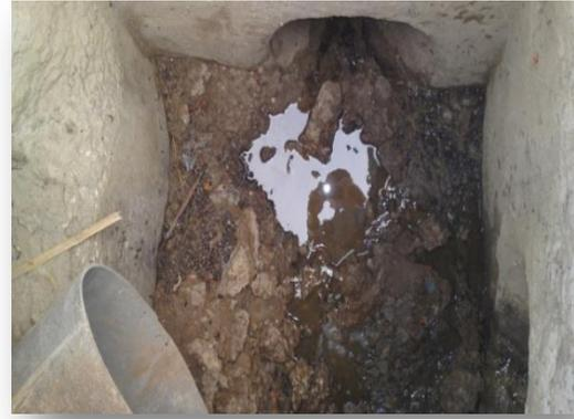
**Figures II.3 :** le béton de regard est de mauvaise qualité (la dégradation de béton).
