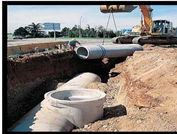
**Figure VIII.6-** pose de conduite avec une pelle
