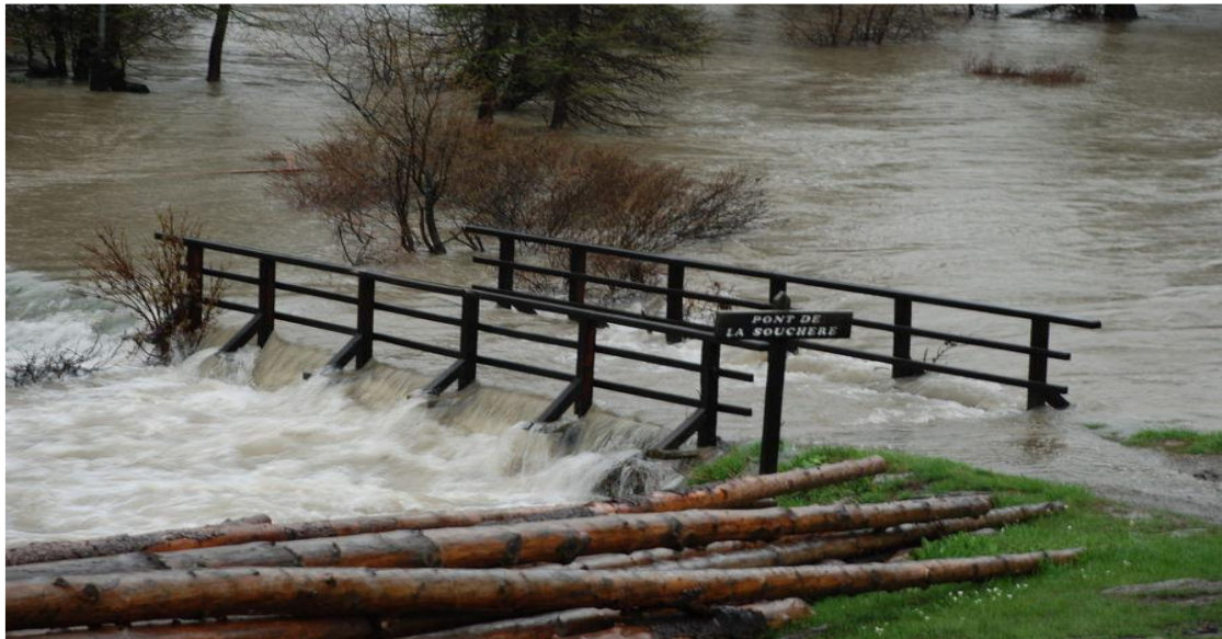
Figure II-2 : Exemple d'une crue torrentielle
