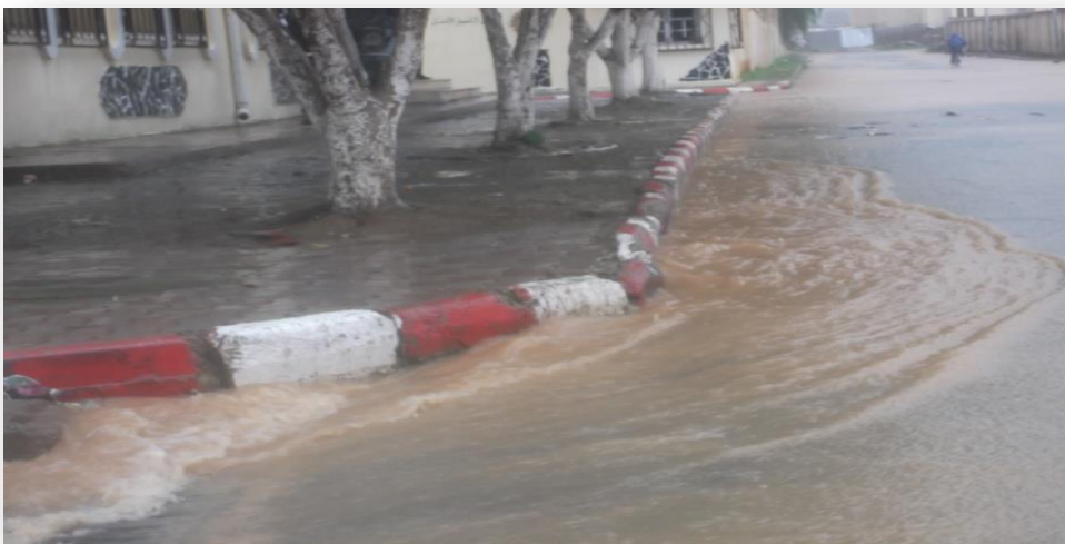
Figure II-6 : Exemple d'inondation dans la ville de Sidi Rached
