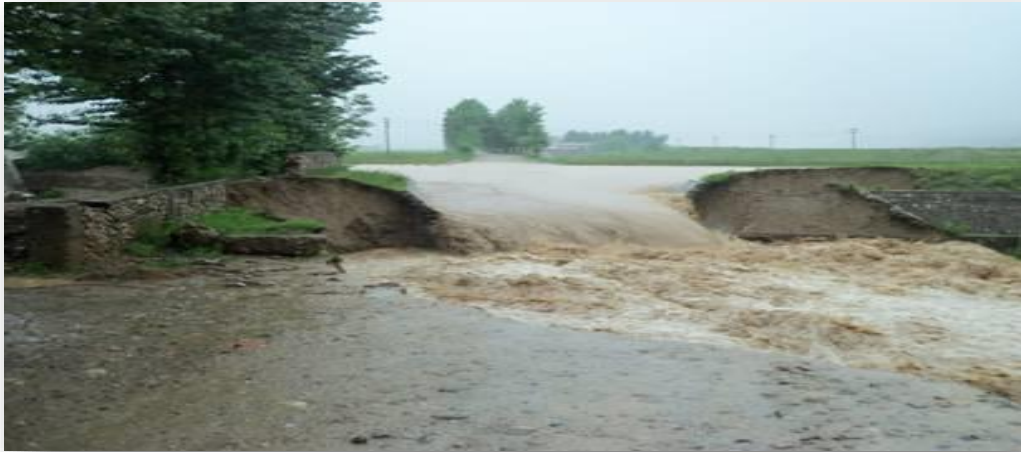
Figure II-5 : Exemple d'inondation par rupture d'une protection
