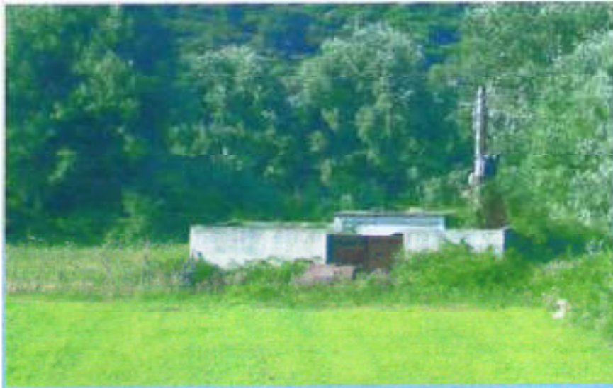
Figure N°V.5: abris de forage typique alimenté en énergie électrique.
