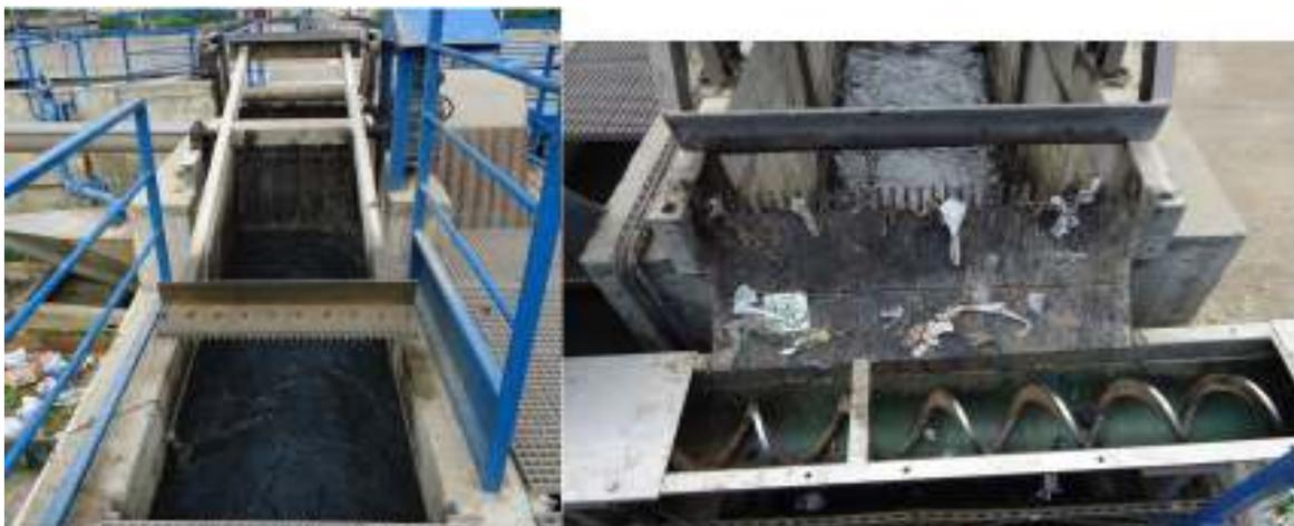
**Figure III – 3 : Dégrilleur.**
