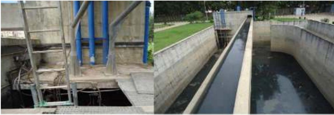
**Figure III – 2 : arrivée des eaux et bassin d'orage.**
