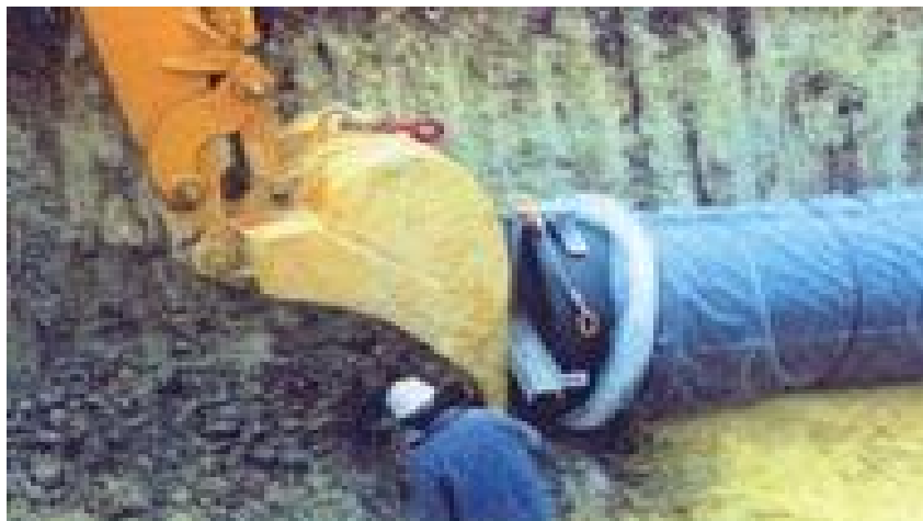
Figure VII.3 : Pose de conduites dans un terrain agressif.
