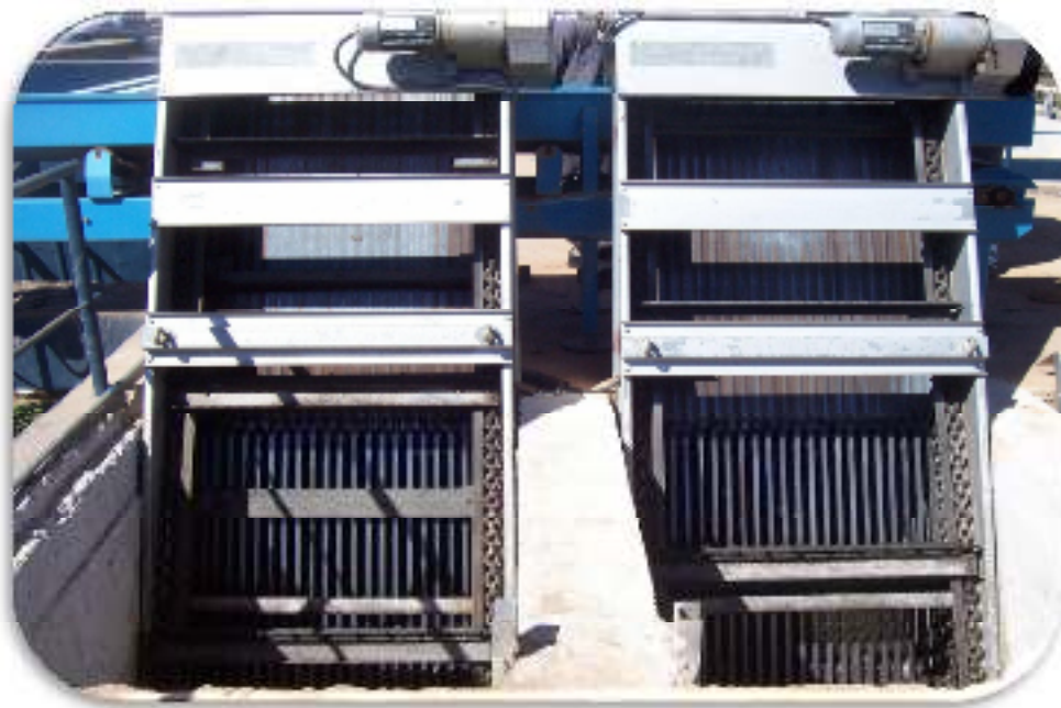
Figure.III.3. Grilles mécanisées fine de la STEP de la ville de Maghnia
