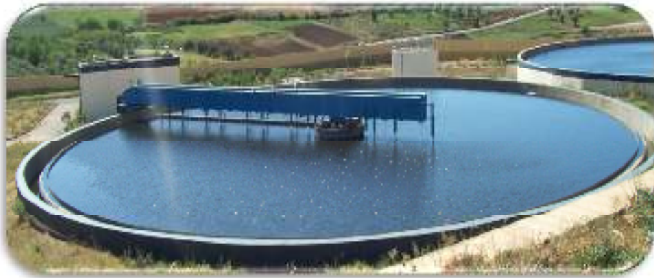
Figure.III.6. Décantation secondaire de la STEP de la ville de Maghnia
