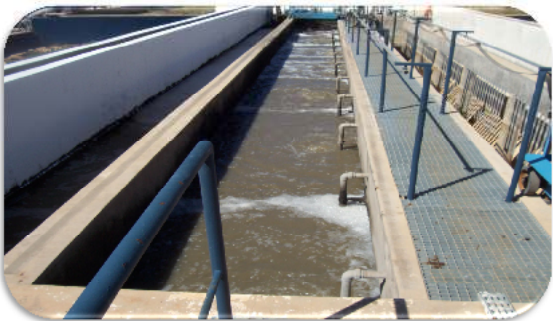
Figure.III.4. Dessableurs déshuileur de la STEP de la ville de Maghnia
