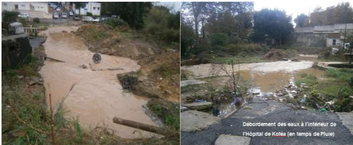
Figure III.2 : Débordement des eaux issues du collecteur Ø600-Béton armé à l'intérieur de l'Hôpital (Cas de Pluie d'une intensité élevée).
