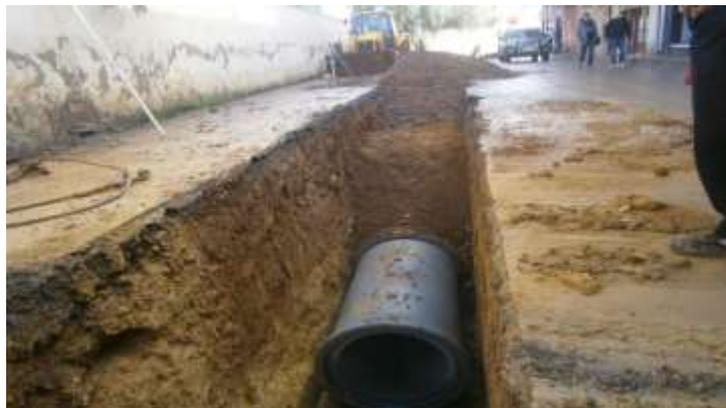
Figure VIII.5 : Pose de la canalisation
