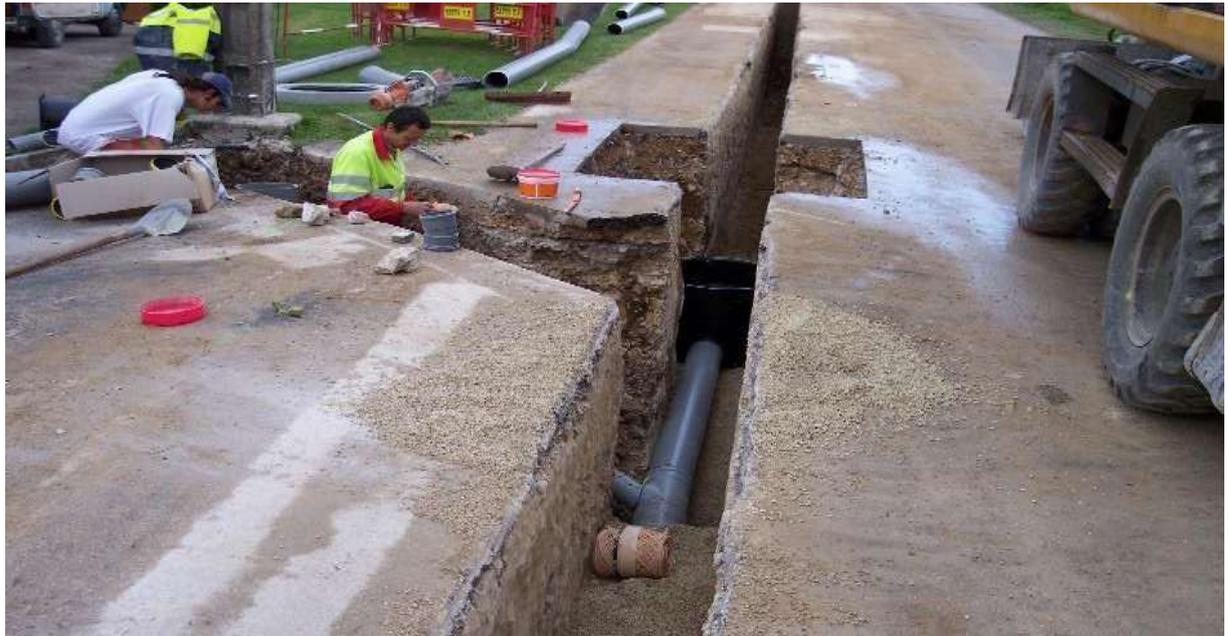
Figure VII.4 : Exemple d'un branchement simple de 50m.
