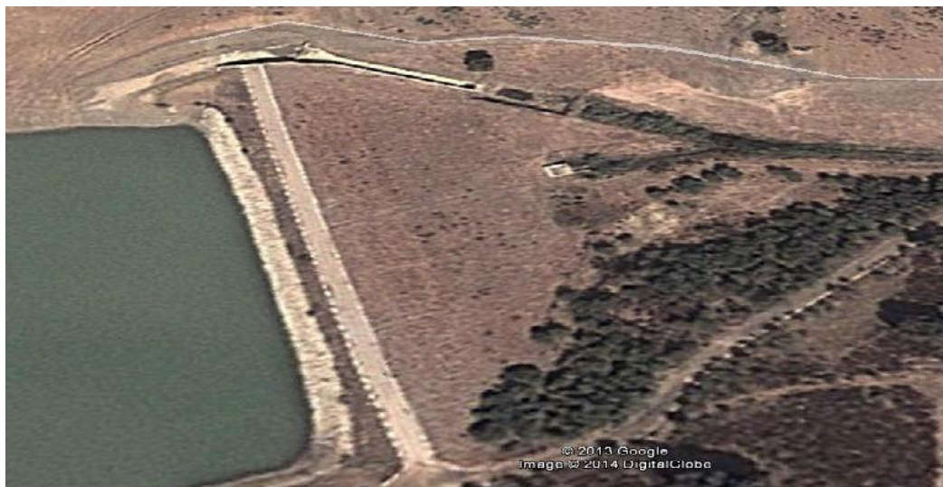
Figure II.2 : vue de la digue de la retenue Rahil
