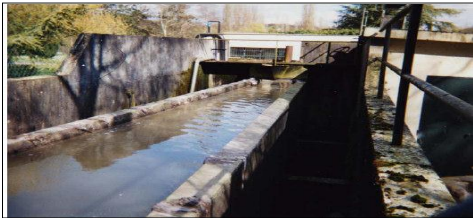
Figure V.2 Exemple de déversoir à seuil double
