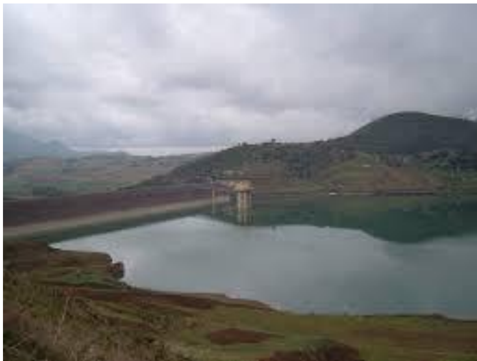
Figure I.9 : Barrage de Boukourdane
