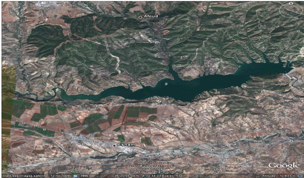
Figure I.1 : Le barrage du TILES DIT
