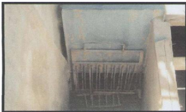
Figure N°5.2: dégrilleur grossier Figure N°5.3 : dessableur, déshuileur
