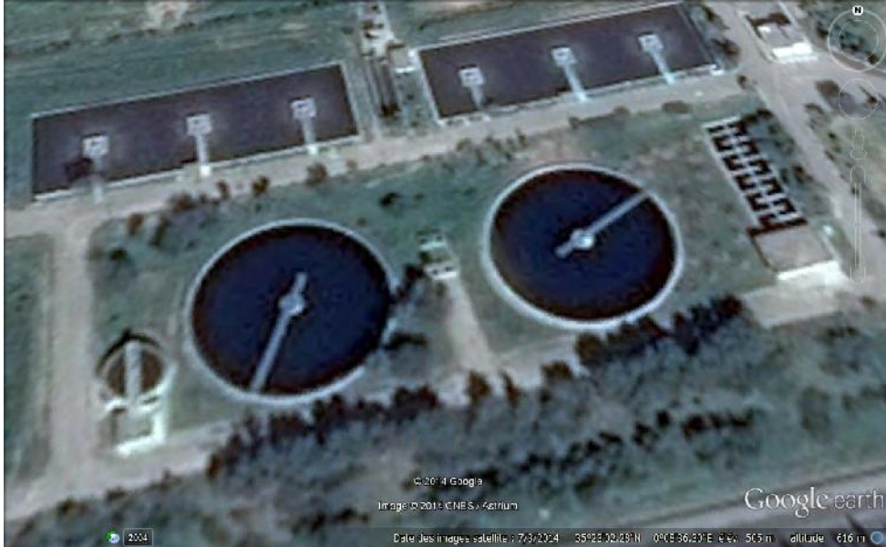
Figure N° 5.1 : Station d'épuration des eaux usées de la wilaya de MASCARA.
