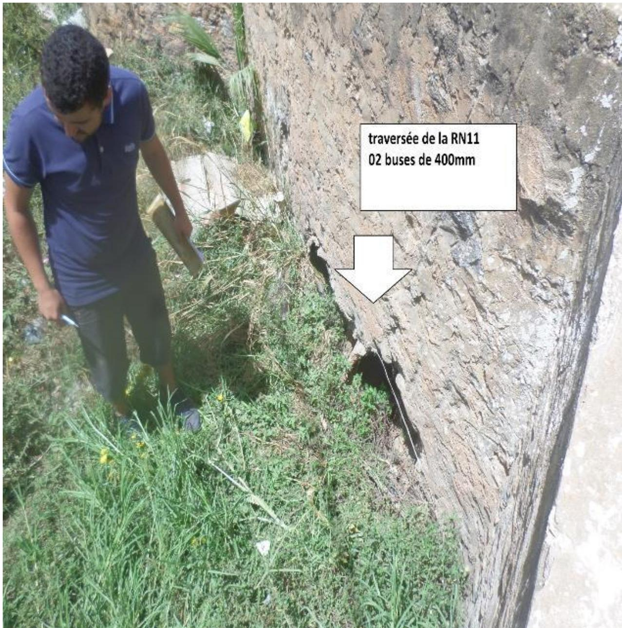
**Figure IV .6: traversée de la RN11 par 2 buses  $\varnothing$  400mm (mars2019)**
