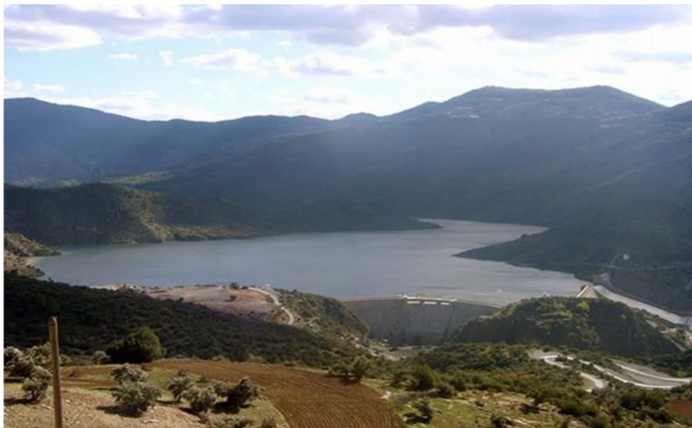
FigIII.1: Vue générale de la cuvette du barrage de Tichy-haf
