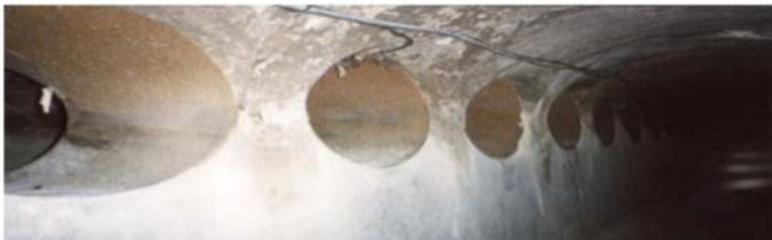
Figure VI-10 : Exemple d'un ouvrage type "trou dans le mur"
