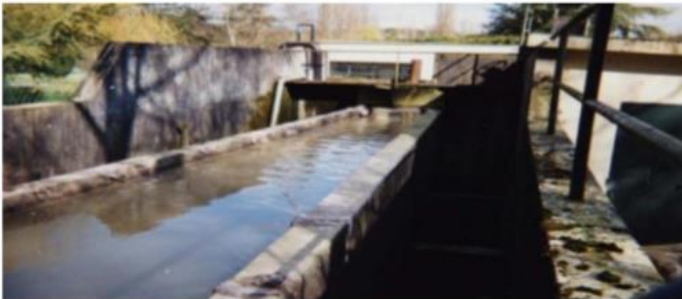
Figure VI-10 : Exemple de déversoir à seuil double
