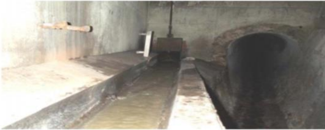
Figure VI-9 : Exemple de déversoir latéral à seuil simple
